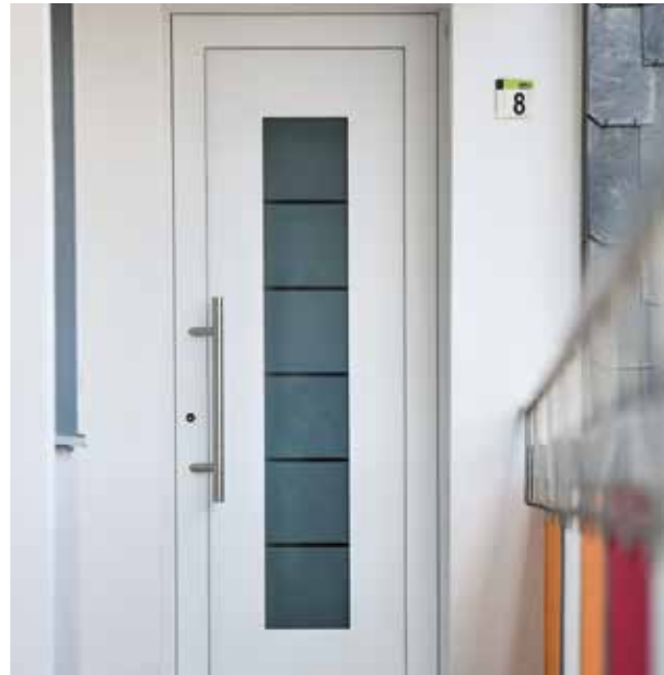
Gut gedämmt: Die neuen Wohnungstüren bieten eine bessere Wärme- und Schallschutztechnik.
