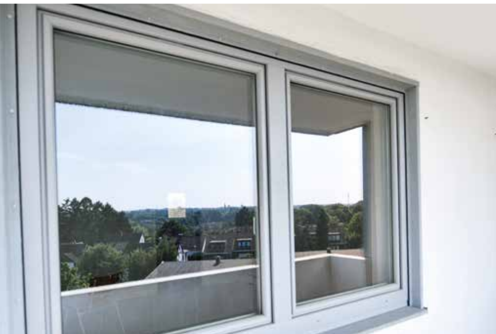
Alles schön dicht: Fenster, die vor 2000 eingebaut wurden, haben wir durch neue ersetzt.
