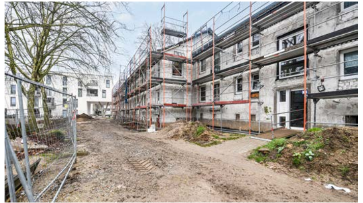
► Elisabeth-Selbert-Straße Energetische Sanierung
