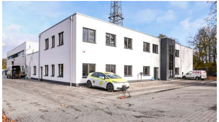
► Gustavstraße Neubau technisches Kompetenzzentrum
