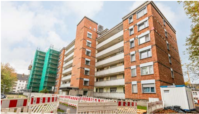
► Feldstraße Energetische Sanierung
