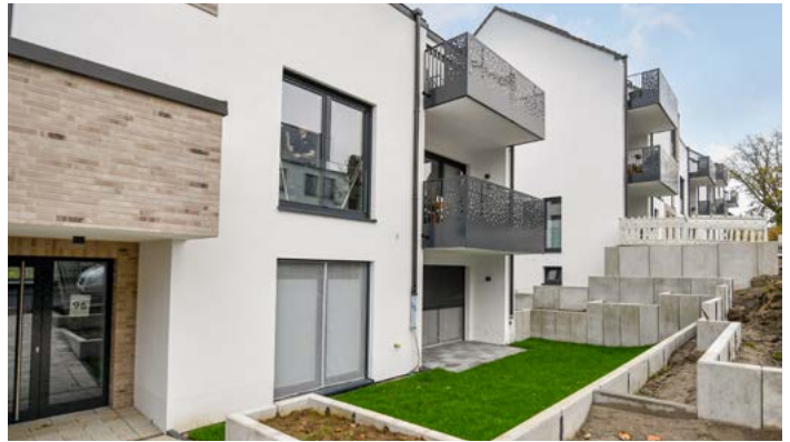
► Quellenstraße Neubau Mehrfamilienhäuser
