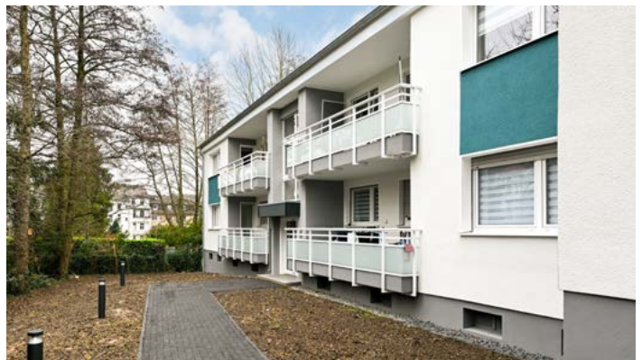
► Thüringer Straße Energetische Sanierung
