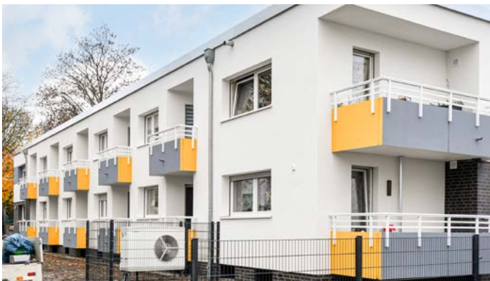
► August-Schmidt-Straße Energetische Sanierung
