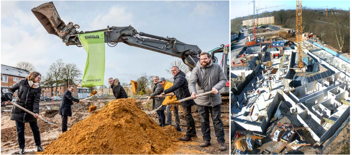
Links: Der feierliche Spatenstich markiert den Baustart an der Filchnerstraße. Rechts: Die Arbeiten an den Fundamenten sind in vollem Gange.
