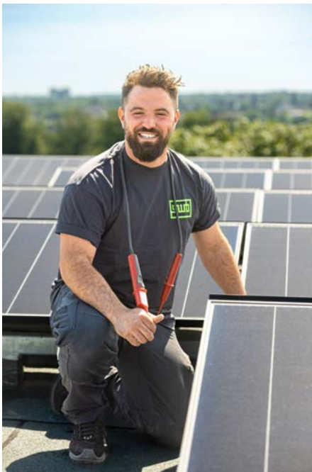
Im Einsatz für die Energiewende: DBF-Mitarbeiter bei der Arbeit an einer Photovoltaikanlage.
