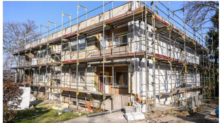
► Völklinger Straße Energetische Sanierung
