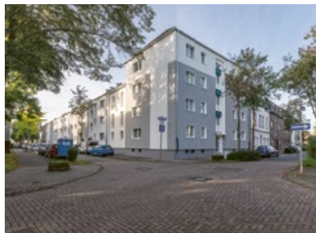
► Roonstraße / Goebenstraße Fassadensanierung
