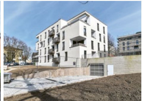
► Elisabeth-Selbert-Straße Neubau Mehrfamilienhäuser
