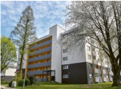
► August-Schmidt-Straße Energetische Sanierung
