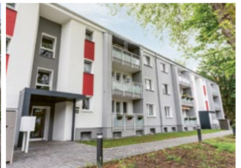
► Thüringer Straße Energetische Sanierung
