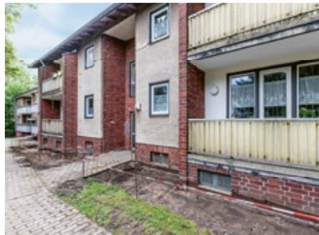
► Thüringer Straße Energetische Sanierung
