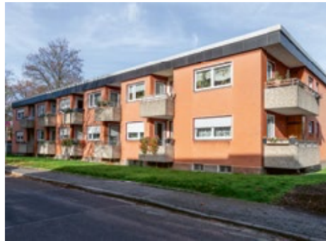
► August-Schmidt-Straße Energetische Sanierung
