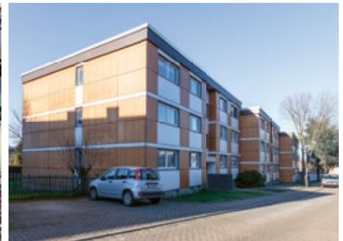
► Vöklinger Straße Energetische Sanierung
