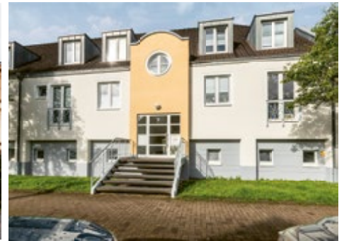
► Düsseldorf Straße Fassadensanierung
