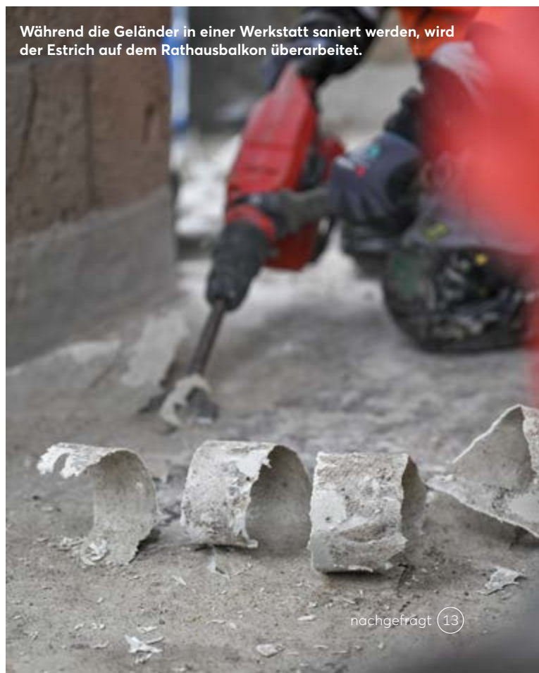
Die alten Geländer wurden von der Bodenverankerung abgetrennt.
